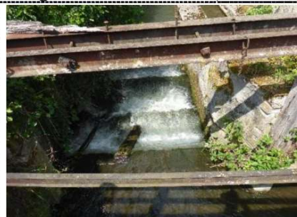
Pertuis de l'ancienne vanne de décharge (vue amont)
